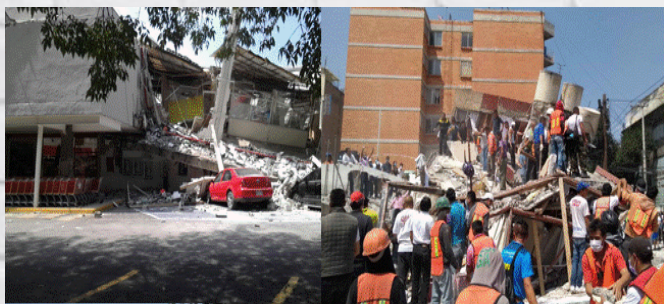
Edificios derrumbados se registran luego del temblor registrado en los límites de Morelos y Puebla
