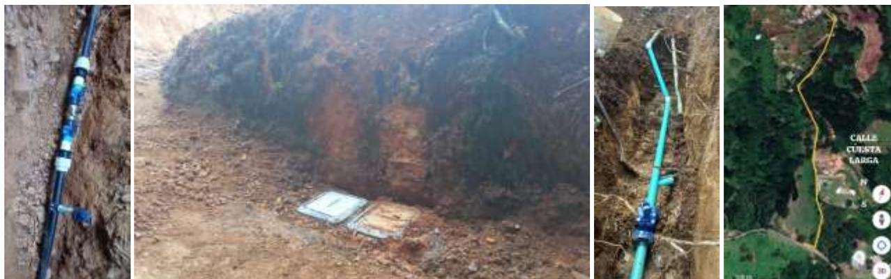
**Descripción de las imágenes:** Tubería de polietileno, reductoras de presión y cajas de registro con tapa colocadas a lo largo de la red de distribución.
