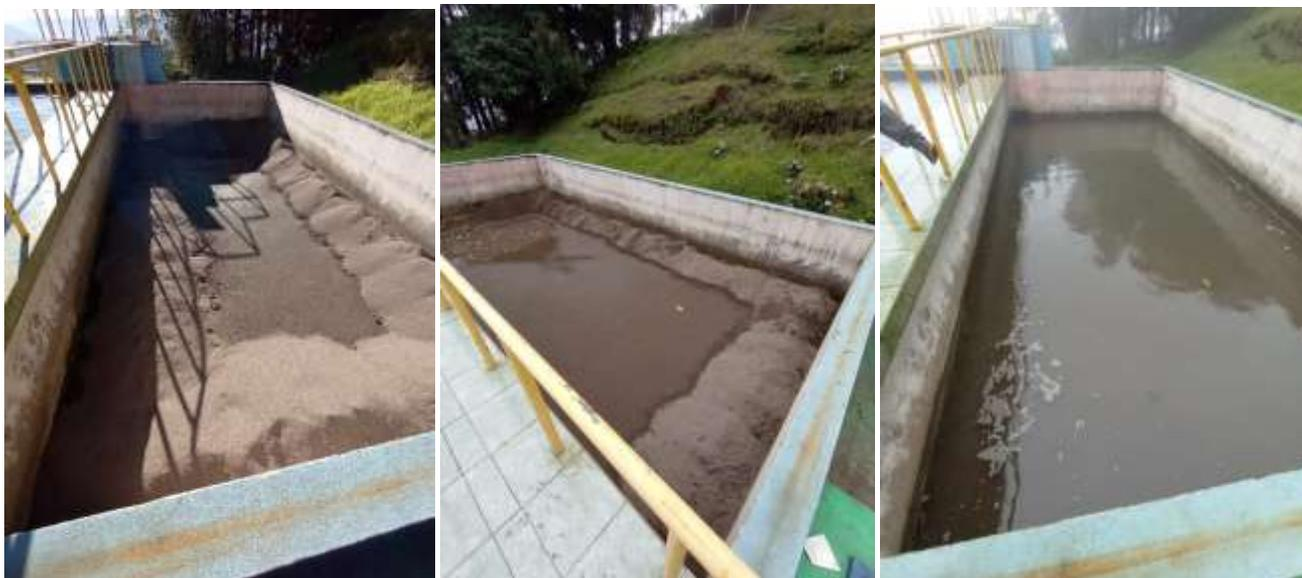
**Descripción de las imágenes:** Cambio de arena piletas del sedimentador filtración lenta.
