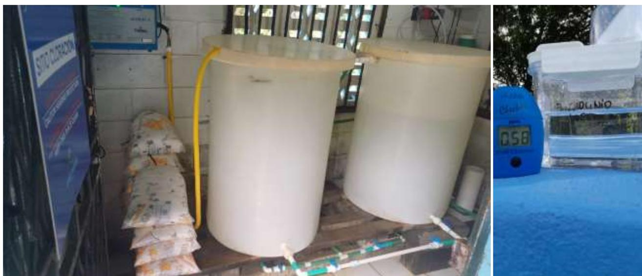
**Descripción de las imágenes:** Sitio de cloración principal a base de electrólisis que transforma la sal en hipoclorito de calcio (Cloro) y dispositivos para determinar la cantidad de cloro residual.
