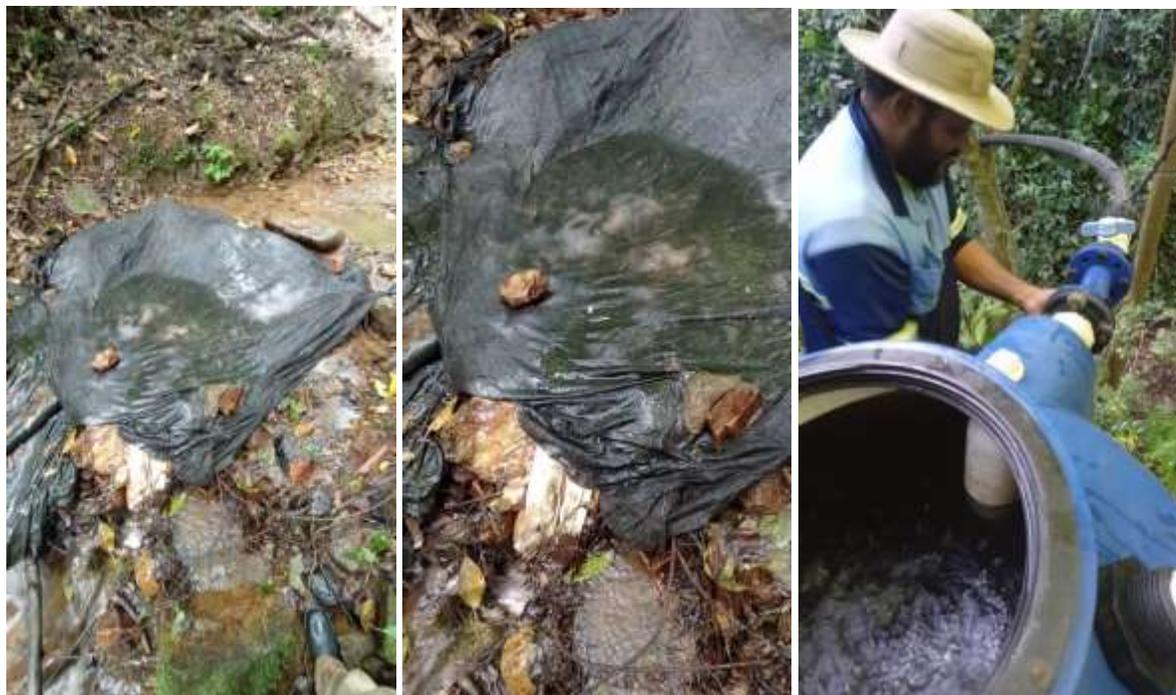
**Descripción de la imagen:** Limpieza de toma y de filtros a entrada de tanque de prefiltración.
