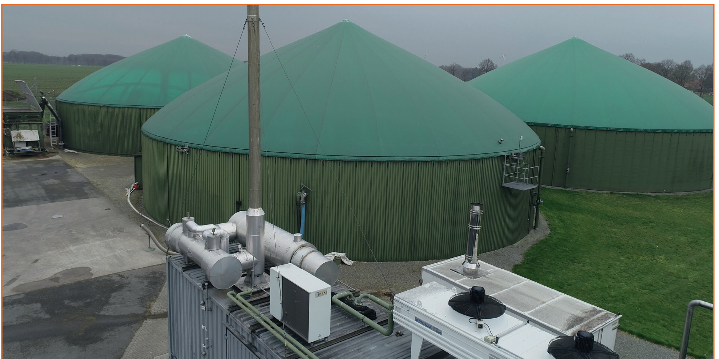
Figure 1: Digester of Bioenergie Eiskamp GmbH & Co. KG
