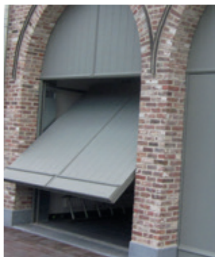
Buiten de gevel draaiende kantelpoort
