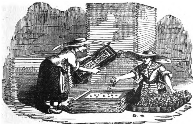
Fig. 49. — Châssis en verre pour l'enfleurage.
