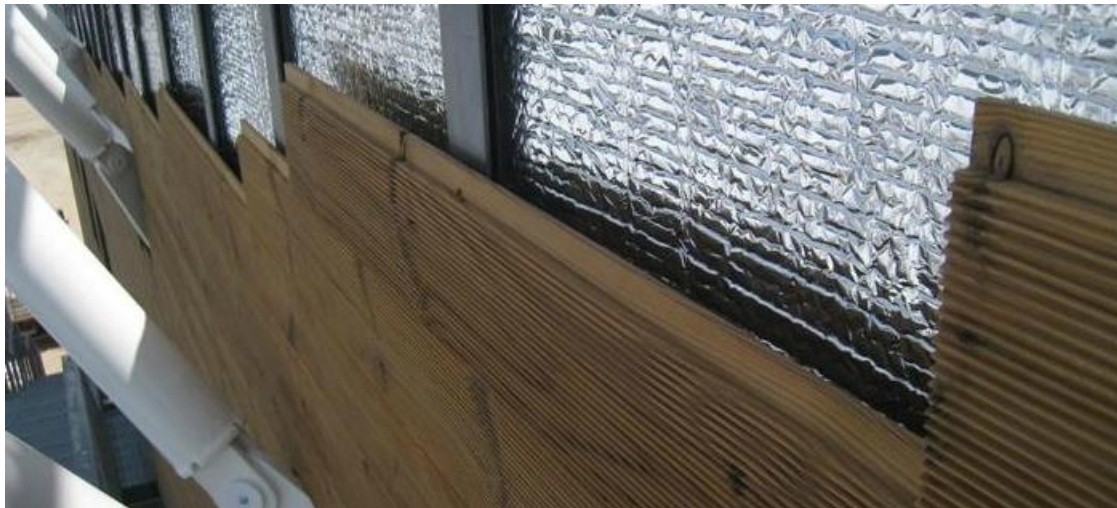
Figura 2 - Esempio CAPPOTTO ESTERNO RIFLETTENTE SA.M.E.
