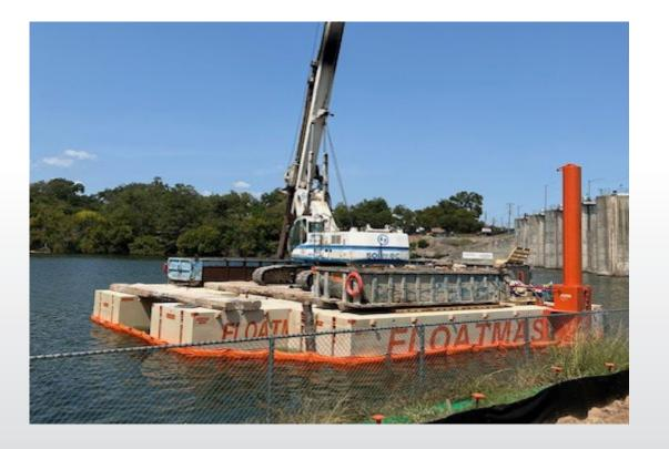
INTEGRAL BARGE TO BARGE LOCKING ASSEMBLY
