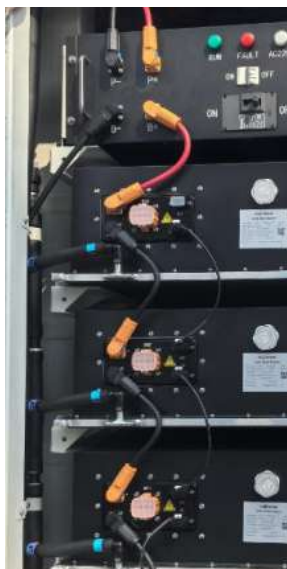
Figura 6-7-2 (4) Immagine del connettore del cavo di comunicazione e alimentazione tra Pack e Rack
