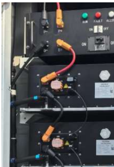
Figura 7-1-1 (2) Collegamenti dei cavi di alimentazione
