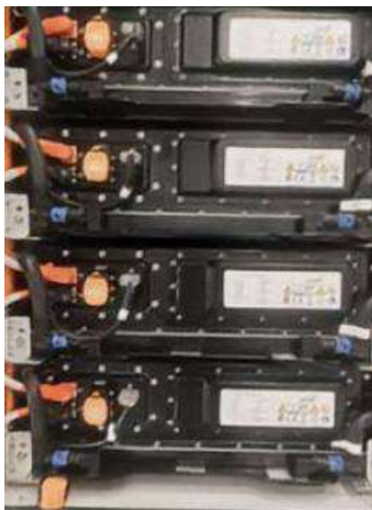
Figura 6-7-2 (4) Immagine del connettore del cavo di comunicazione e alimentazione tra Pack e Rack
