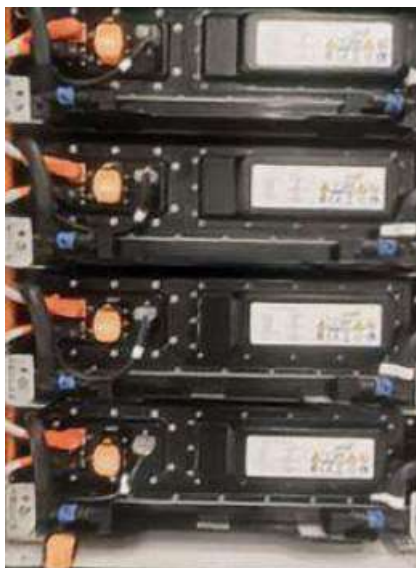
Figura 7-1-1 (2) Collegamenti dei cavi di alimentazione
