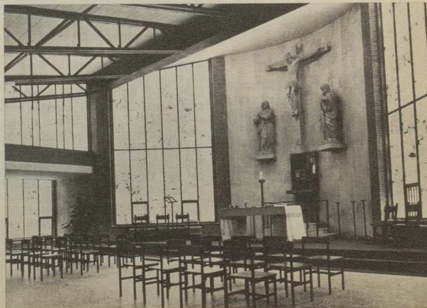
Interior de la capilla, aún inacabada.
