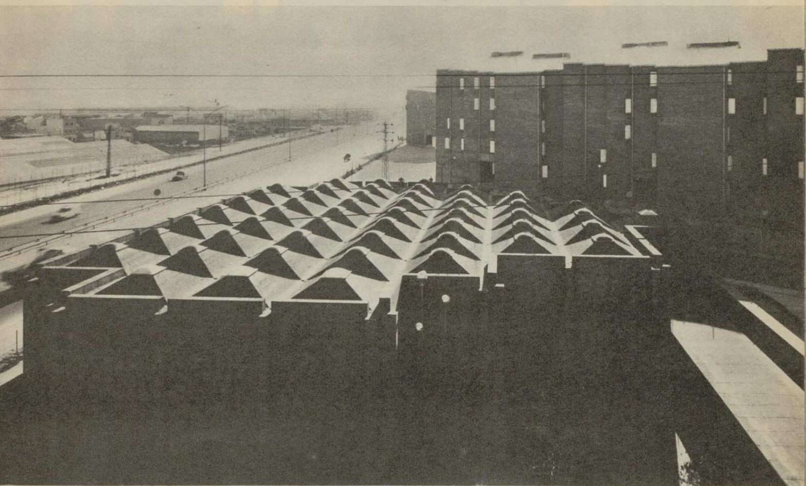
Efecto exterior del conjunto de lucernarios de la nave parroquial.
