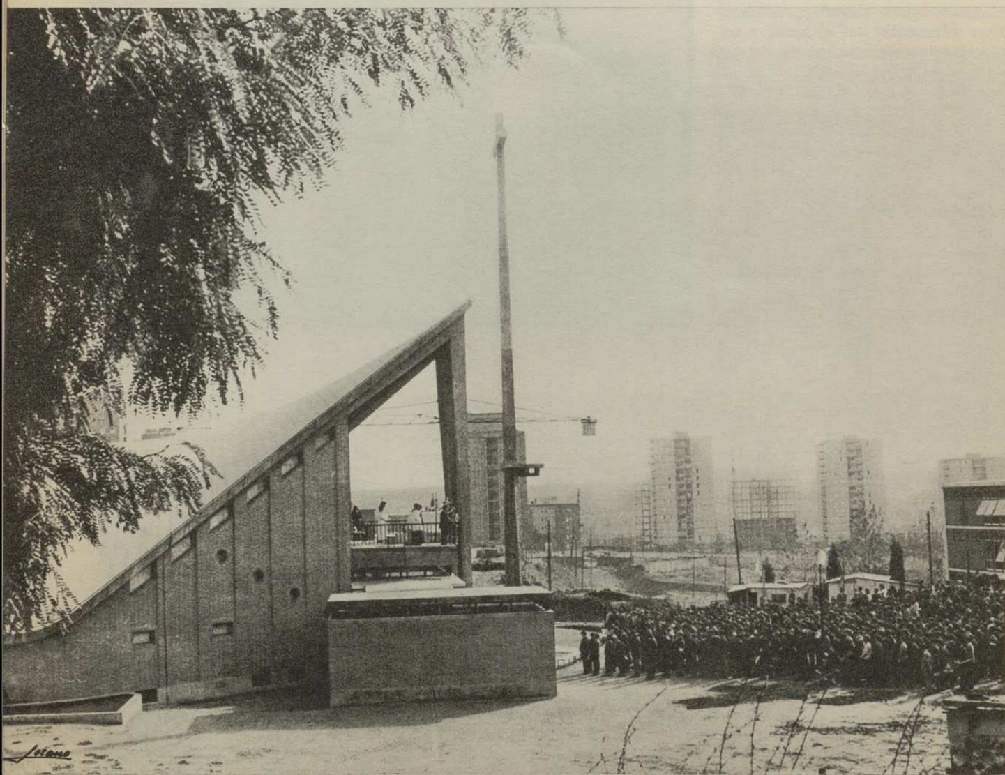
Misa de campaña en la «capilla abierta». Ambiente de barrio en construcción.
