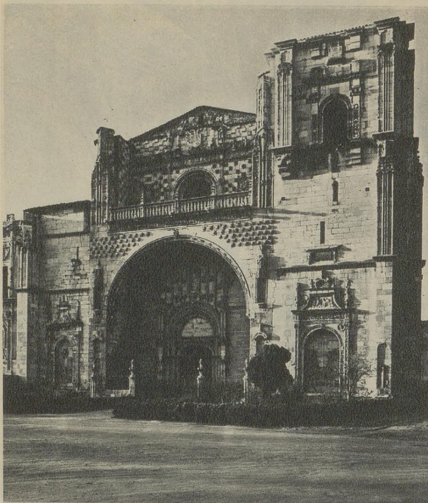
RENACIMIENTO. Fachada de la iglesia del antiguo hospital de San Marcos, que está siendo actualmente restaurado.
