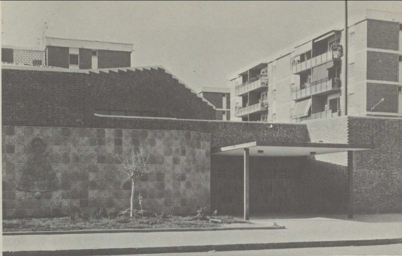
PARROQUIA DE «NTRA. SRA. DE LOS LLANOS» (Barrio de San Ignacio de Loyola, Carabanchel, Madrid). — Presencia sencilla y digna. Ambiente acogedor y perfecta adaptación plástica con las edificaciones del barrio, avalan el acierto de estos nuevos modos de presentarse la Iglesia en la sociedad del desarrollo. Las cualidades del interior de esta Parroquia han sido expuestas en el núm. 21 de nuestra Revista
