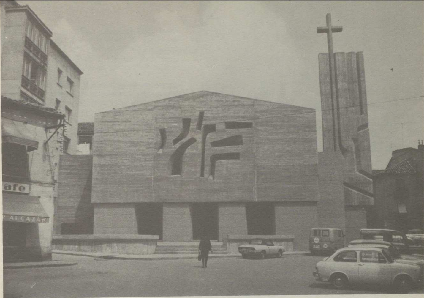
«El Salvador», Soria.—Vista desde el atrio de entrada. Su volumen no es elevado, pero domina el conjunto, quedando como arropado por el bloque de seis plantas que alberga las viviendas y dependencias parroquiales
