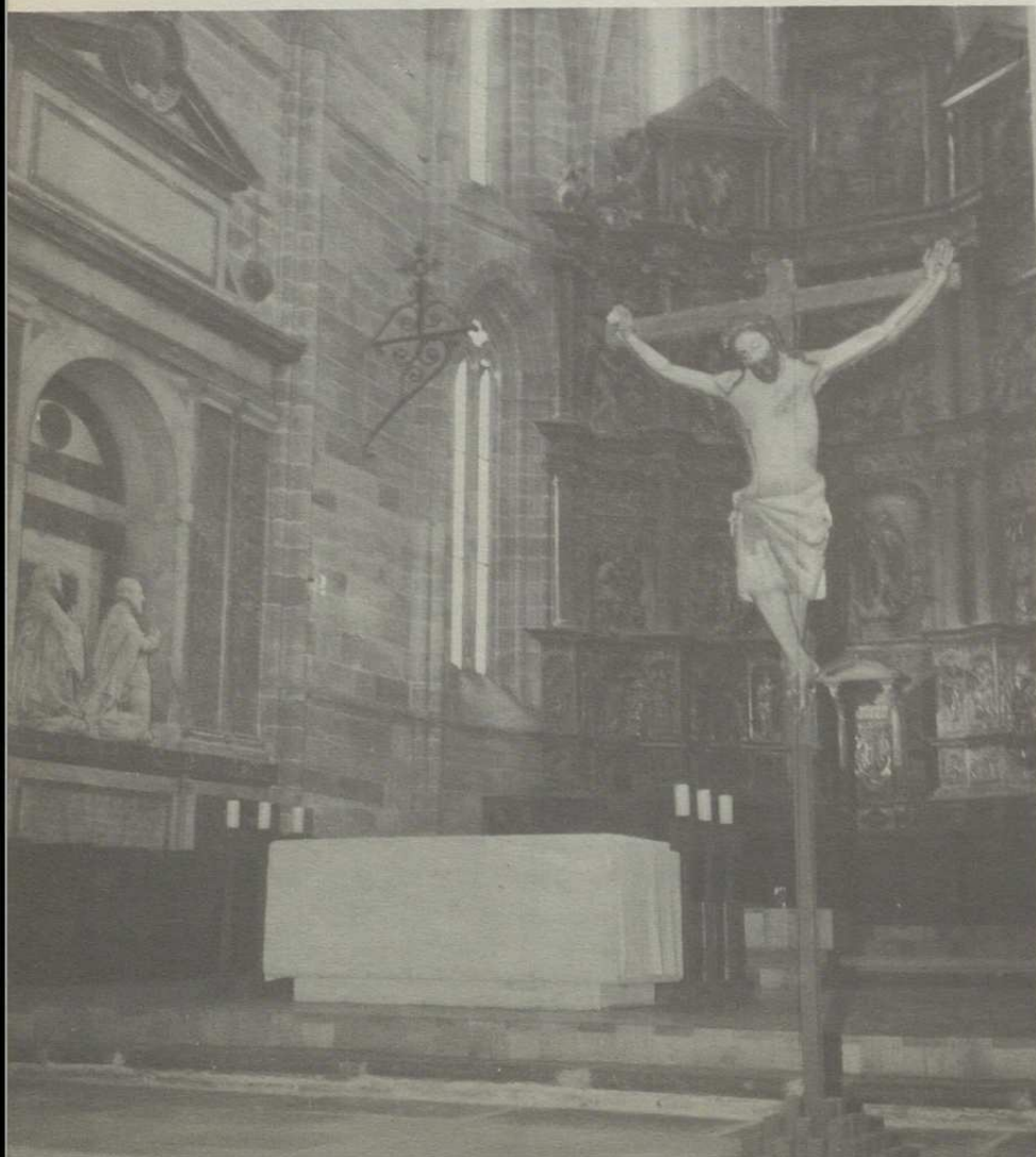
Capilla Mayor. —Valoración de lo antiguo, realzando el retablo y sepulcros al suprimirse el altar de mármol (lleno de gradines con su candelaría y floreros) puesto a principios de este siglo. El descenso de nivel del suelo ha permitido mejor visibilidad. La supresión del zócalo de madera de la sillería lateral dejó al descubierto plenamente las estatuas orantes. La sillería baja al fondo del ábside sirve de base a todo el retablo. Bien delimitado el espacio cultural, destacan ordenados altar, ambón y sede
