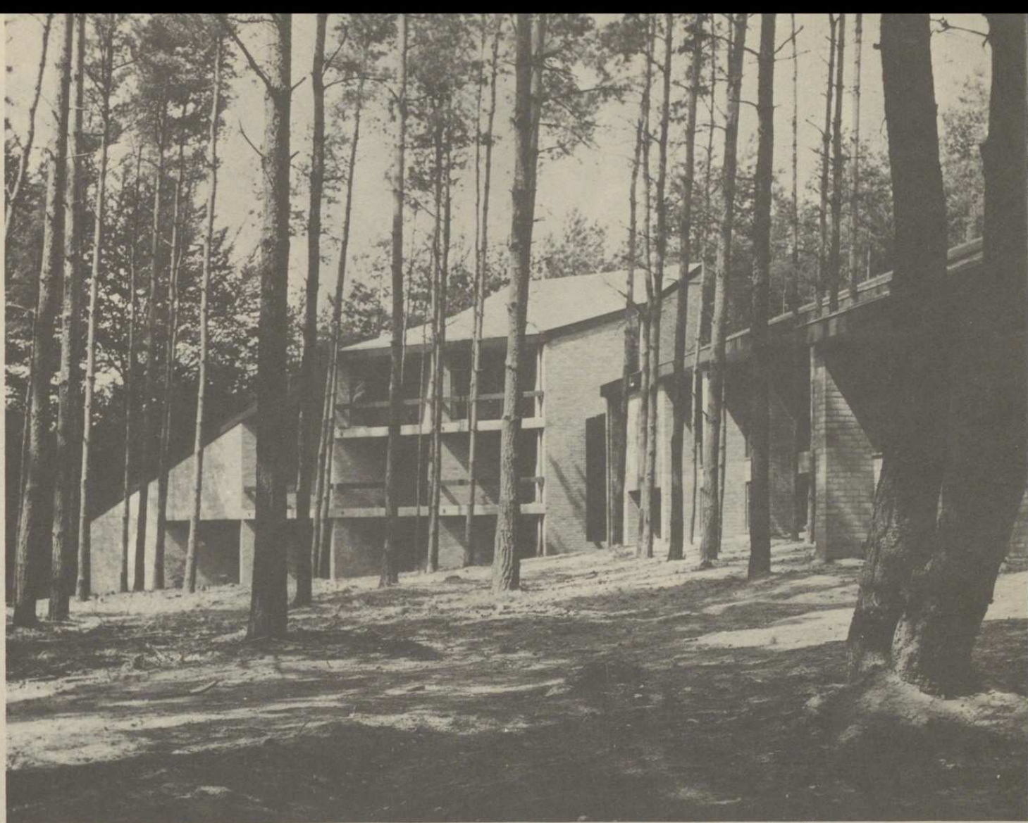
MONASTERIO DE SAN ANDRES, en Ottignies (Bélgica). Arquitecto: Jean Cosse, 1971.—Casa principal. Vista de conjunto: fachada Sur
