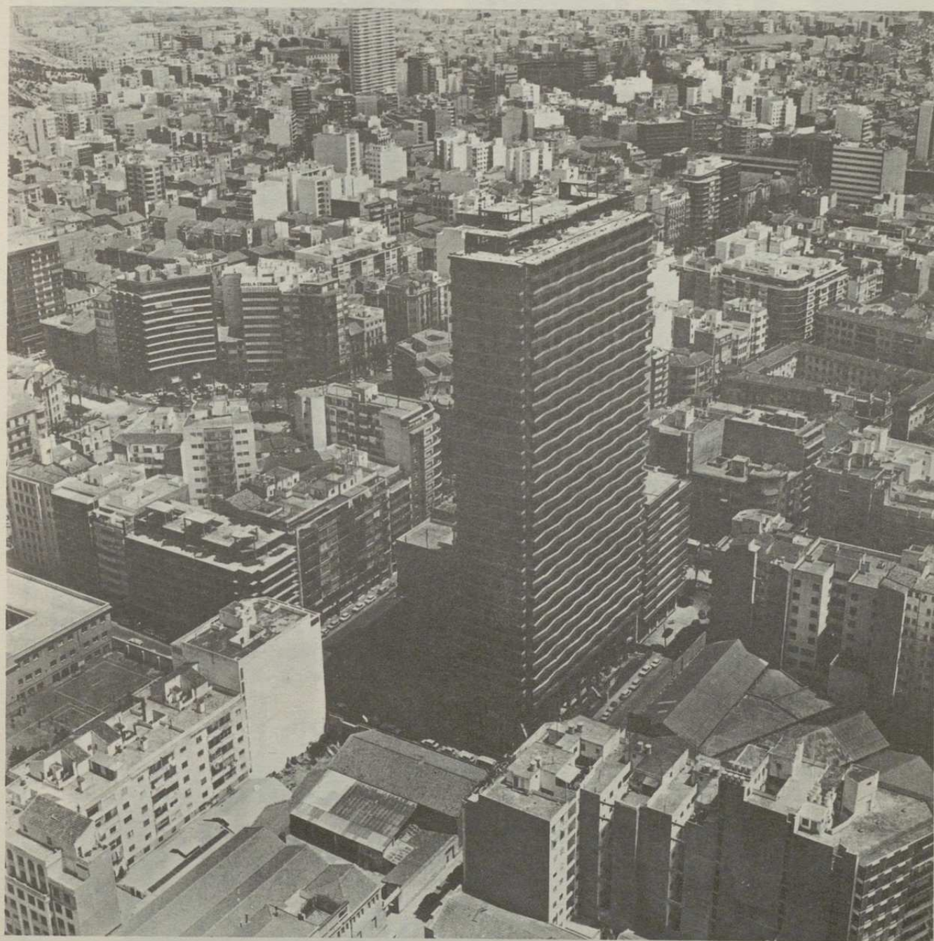
Hotel Riscal, en Alicante Arquitecto: D. Francisco Muñoz Lloréns Construcciones SAN MARTIN, S. A.
