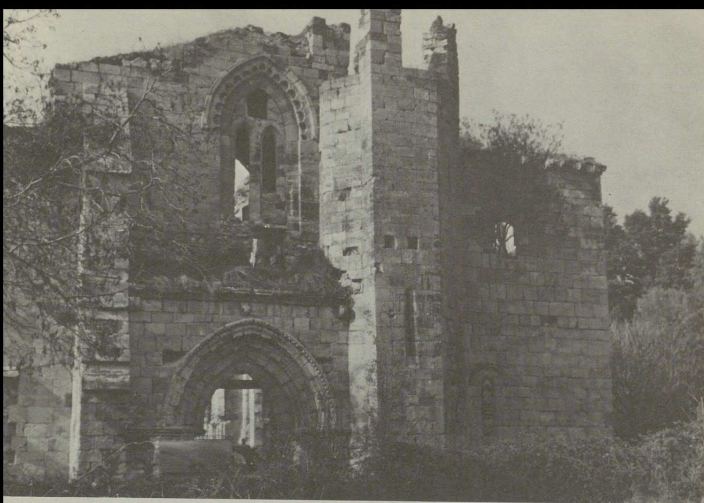
Visión lateral —fachada sur— con portada de acceso al templo y gran ventanal de la tribuna sobre el crucero. El torreón de enmarque es construcción algo posterior, que aloja una elegante escalera de caracol, en buen estado de conservación
