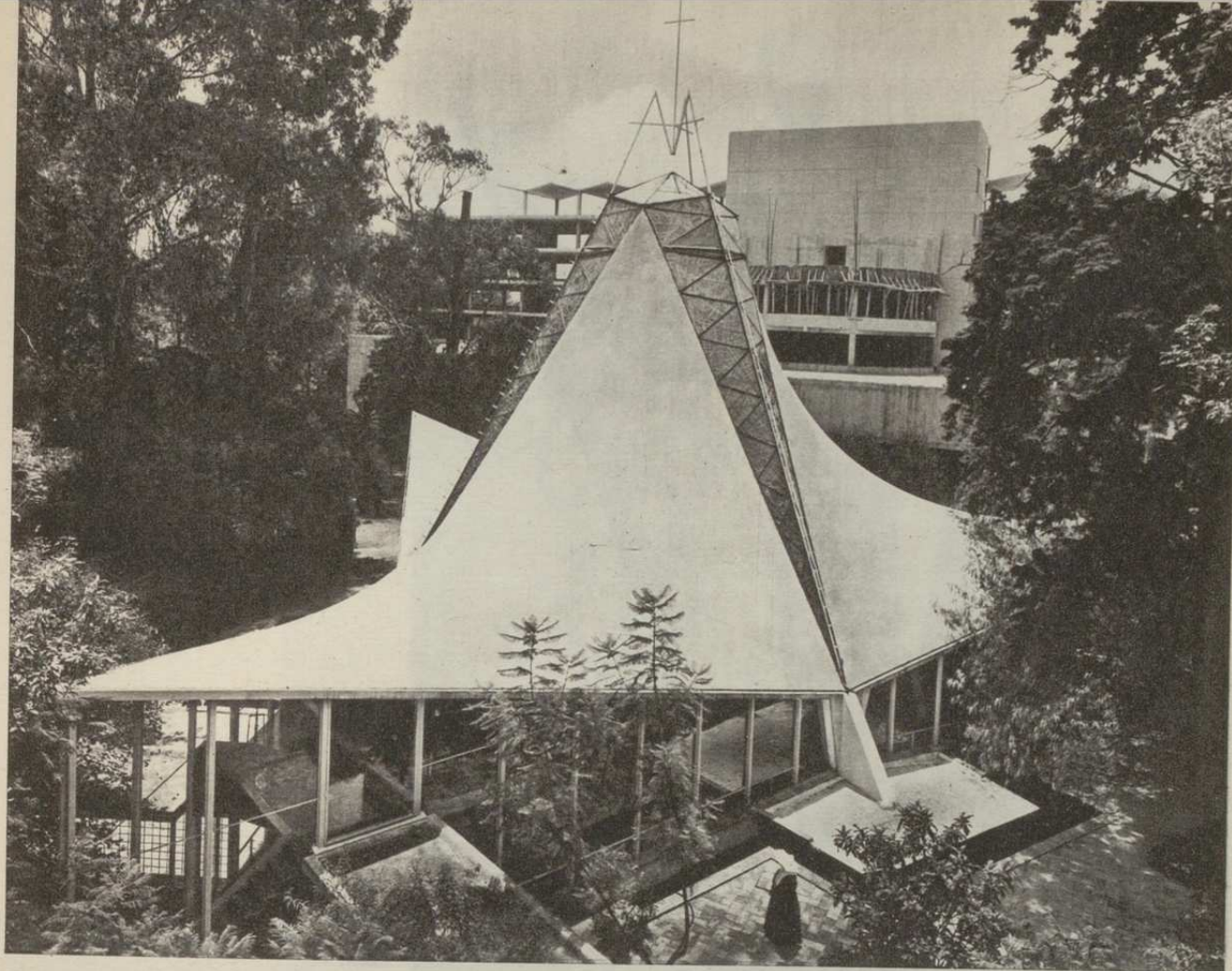
Capilla de las HH. de San Vicente de Paúl. Coyoacán, México, D. F. Arquitecto, Enrique de la Mora; colaborador arquitecto, F. López Carmona; arquitecto estructuralista, Félix Candela. Vista de conjunto.
