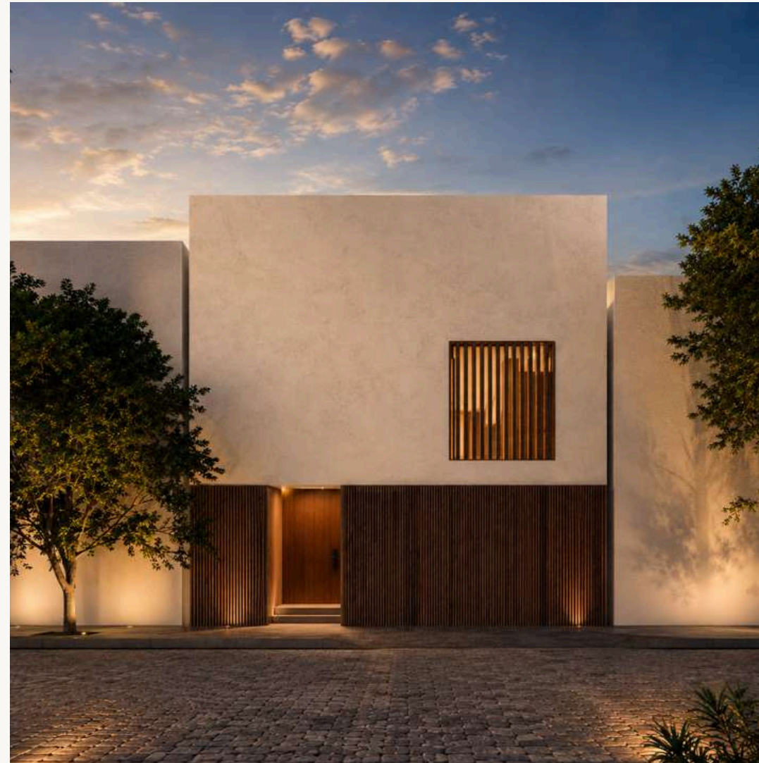
Casa NZ CDMX Privado Construido
