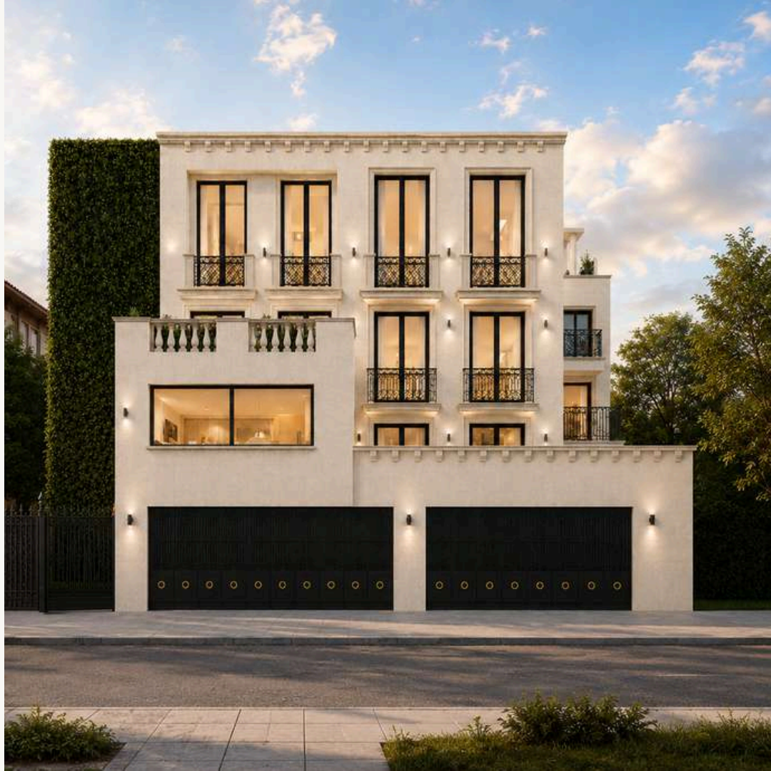
Virreyes I residencial Lomas de Chapultepec Veramont Inmobiliaria Construido
