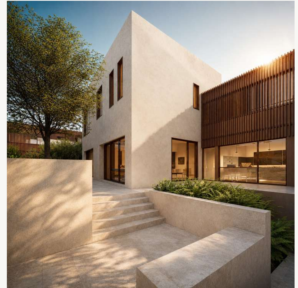
Residencia IG CDMX Privado En Construcción
