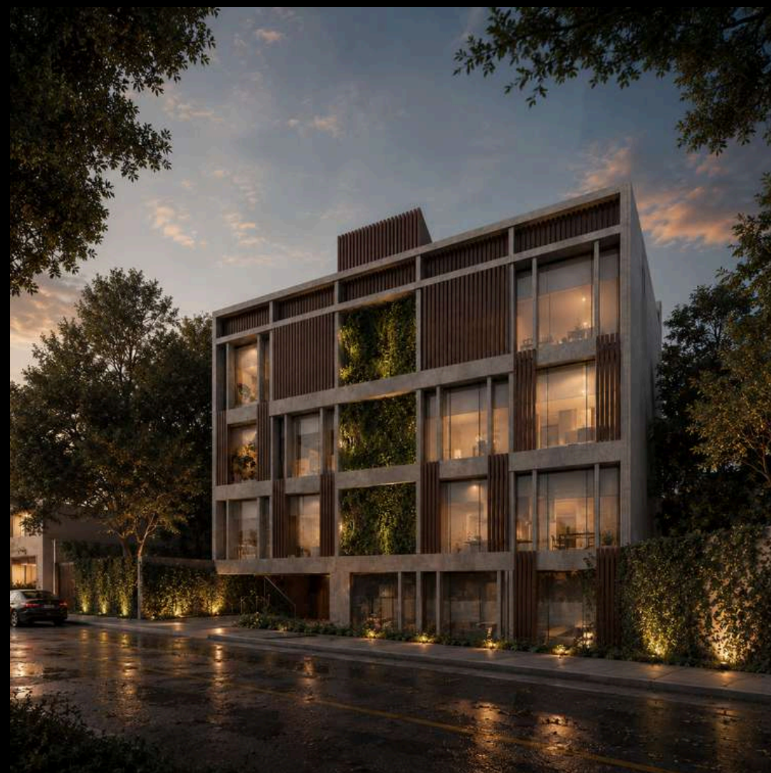
Nombre: Fuentes residencial Lugar: Tecamachalco Cliente: Veramont Inmobiliaria
