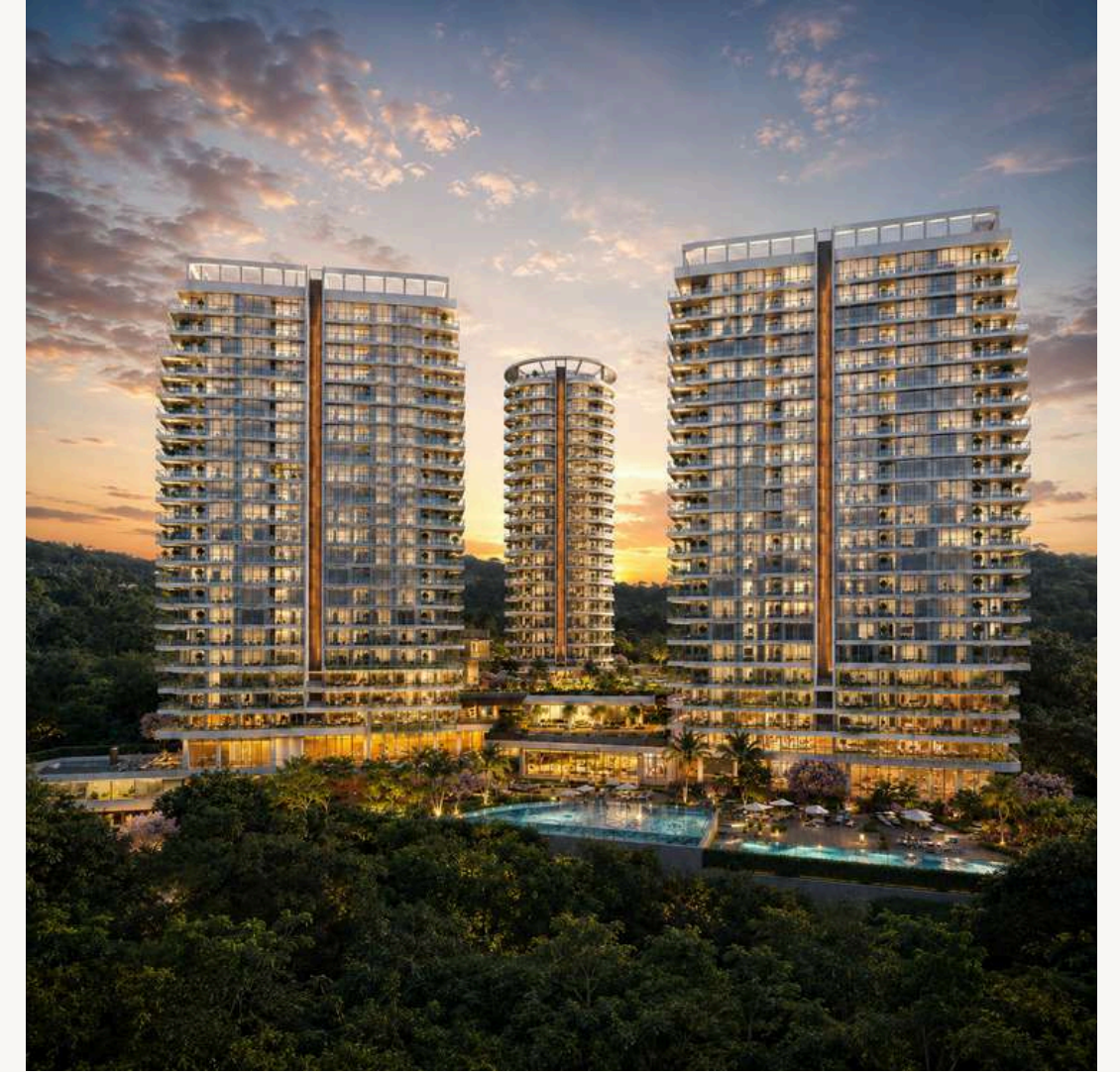
3 C residencial Santa Fe Privado
