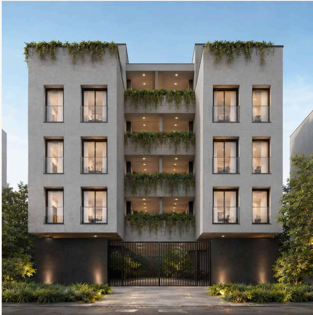
Bocanegra residencial CDMX Privado Construido
