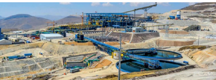
Quellaveco - Minera Anglo American
