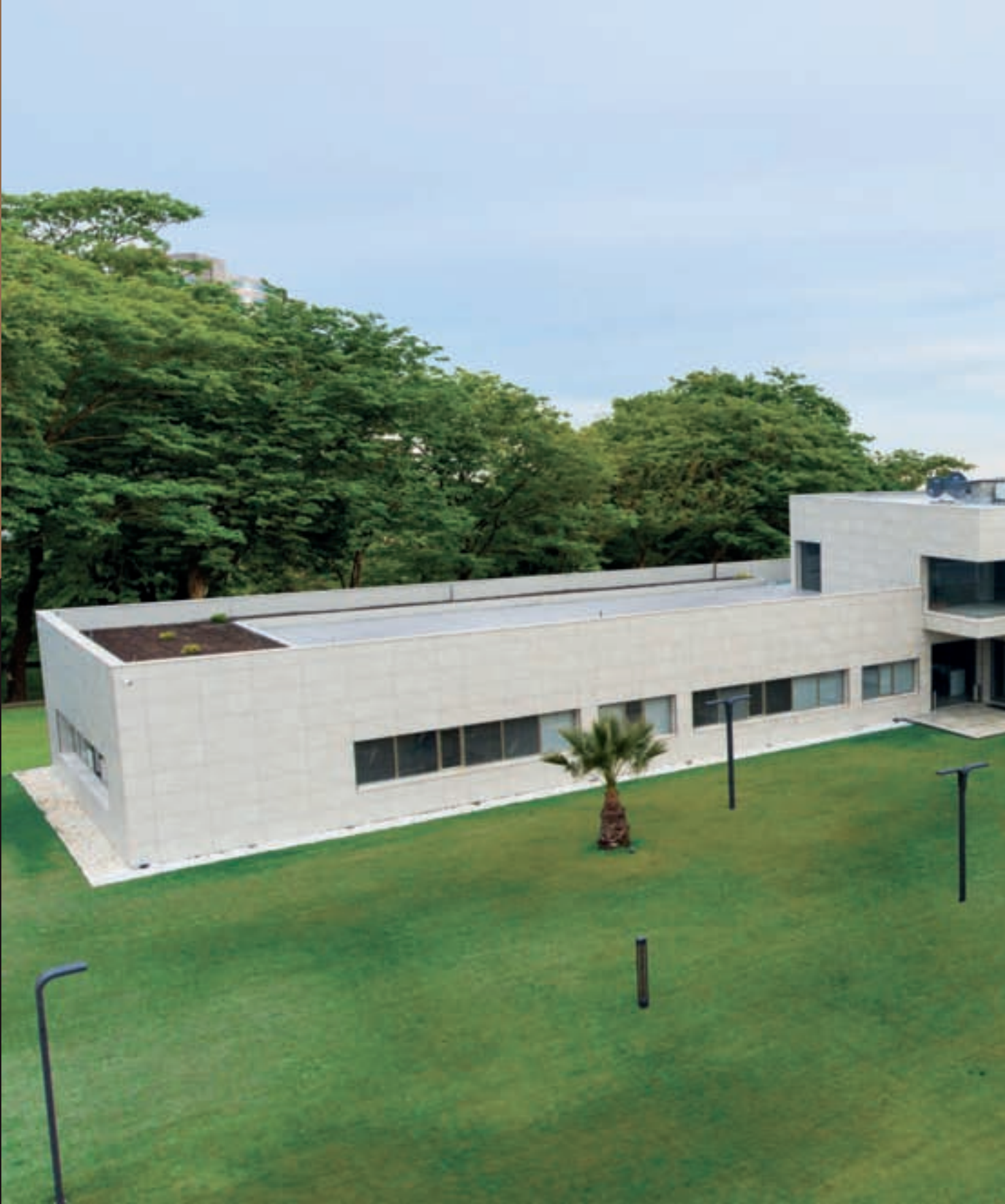
Tire OSB Yönetim Binası Tire, İzmir
