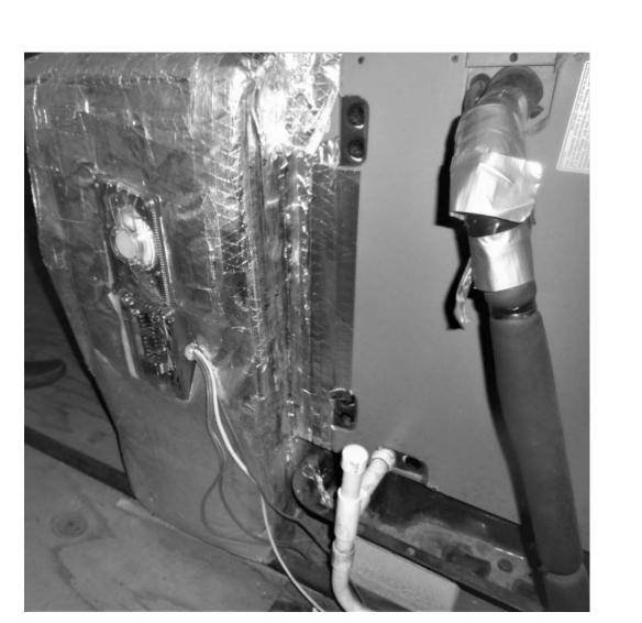
PHOTO 1 EX-AHU-3 RETURN PLENUM SMOKE DETECTOR.
