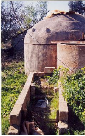
Fotoğraf 29 : Çamurun Süzülmesi (Köşk, 22 Mart 2003)
