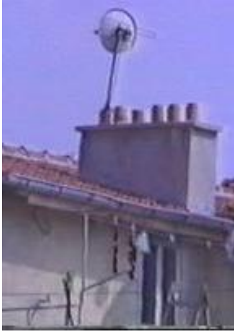
Fotoğraf 131 : Küngün Baca ve Su Oluđu Olarak Kullanımı
