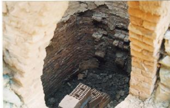
Fotoğraf 66 : Muğla-Bodrum-Torba Fırın içi kemer Yapımından Görünüm 31 Ağustos 2003
