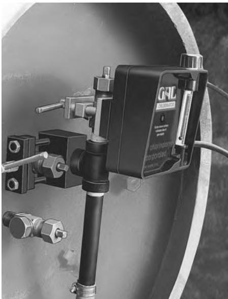
La instalación directamente sobre los recipientes de tonelada presenta varios problemas que generalmente no se encuentran con los cloradores de gas instalados directamente sobre el cilindro. Estos incluyen la introducción del cloro líquido al sistema de gas cuando se utilice un recipiente de tonelada por primera vez, y la acumulación de cantidades excesivas de impurezas dentro de las áreas de entrada del clorinador. El adaptador TAY-200, de
