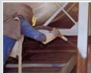
Granallado con Grittall Ausencia de polvo
