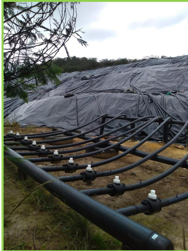
Imagen. Colector Manifold, vaso B.
