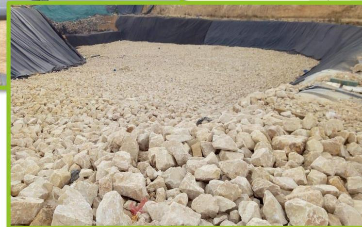
**8.2 IMPERMEABILIZACIÓN DE FONDO:** Se realiza la instalación de geomembrana y geotextil para evitar la infiltración de lixiviados y Prevenir posible contaminación al subsuelo o a las aguas profundas.
