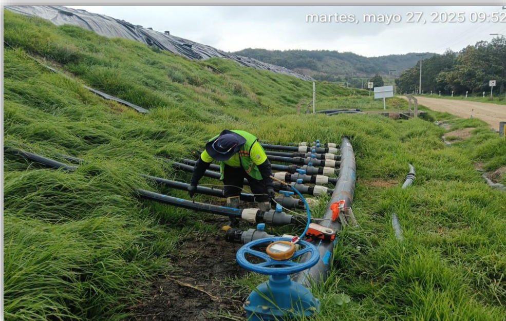
Fuente: Colector manifold B, Vaso C
