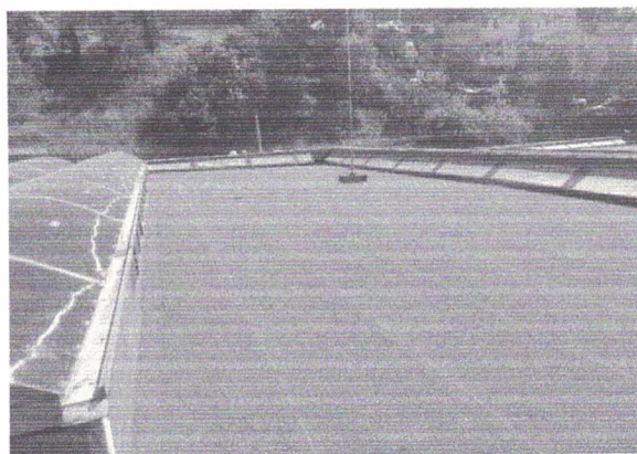
Impermeabilización a base de manto impermeable prefabricado en las cuatro azoteas de los edificios A y B, secciones A y B
