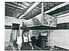
En comedor, falta extractor y la tubería extractora está incompleta
