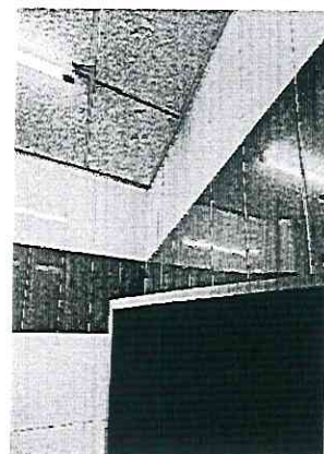
Filtraciones en edificio "D" la techumbre es de panel Multytecho, impermeabilizaron, checar mantenimiento
