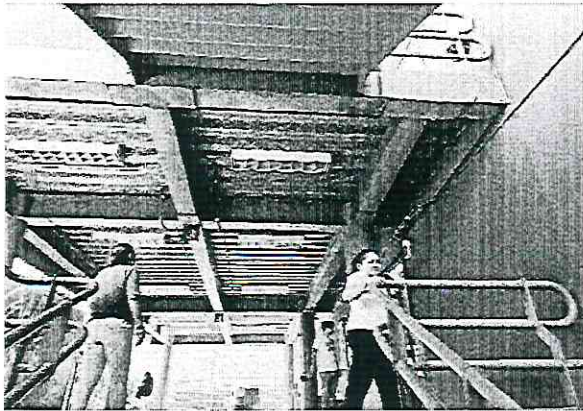
Herrería en general en mal estado requiere pintura
