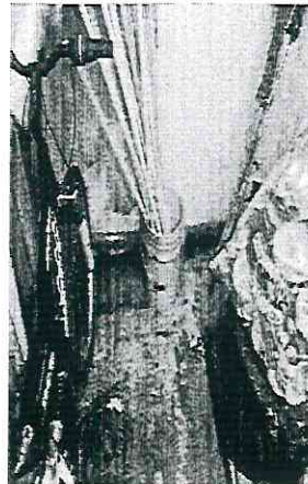
Filtraciones entre edificio "B" y muro de colindancia del Unidad Habitacional Huizachito, falta Flashing
