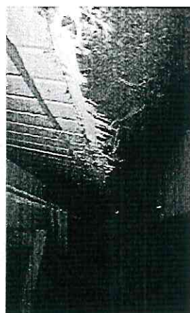
El CANALON de aguas pluviales del Auditorio presenta problemas de fijación y de sellado, lo que ocasiona filtraciones al interior del Auditorio
