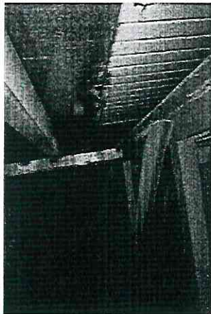
El CANALON de aguas pluviales del Auditorio presenta problemas de fijación y de sellado, lo que ocasiona filtraciones al interior del Auditorio
