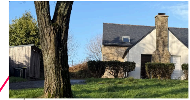
A2b - abri à démolir
