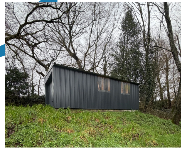
A2a - garage à démolir
