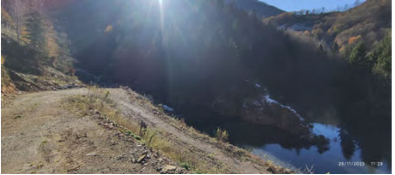
Resim 332. Kızılev ve Elboğa derelerinin kesişim noktası ve HES su tutma alanında kalan köşe
