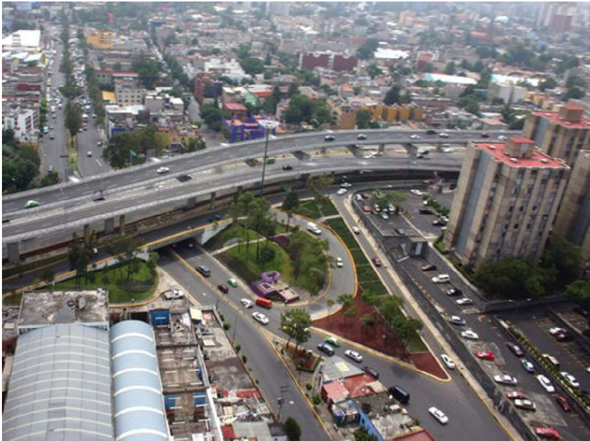
Vistas aéreas del segundo piso del Periférico. Ciudad de México 2004, Sup. Zona de Mixcoac; Inf. Distribuidor Vial San Jerónimo. Foto: INDI
