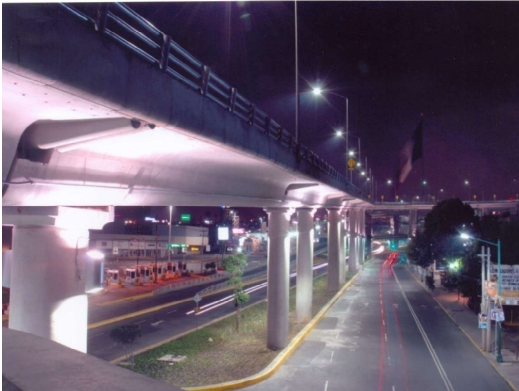
Vista del Segundo piso del Periférico, Ciudad de México. 2004. Zona de San Jerónimo sentido norte-sur FOTO: INDI
