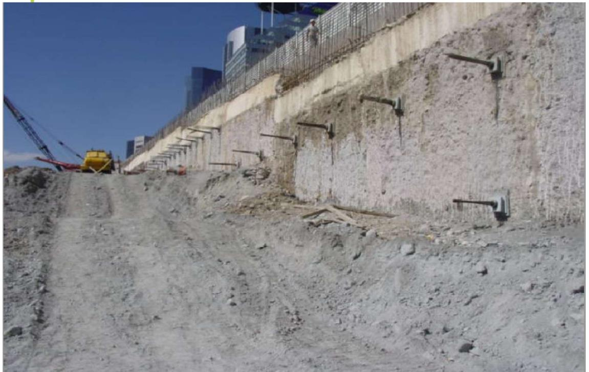
Se puede observar un terreno de baja resistencia por el tipo de anclaje que se observa en la foto. Anclaje para Muros de contención en City, Santa Fe, Cuajimalpa, D .F.
