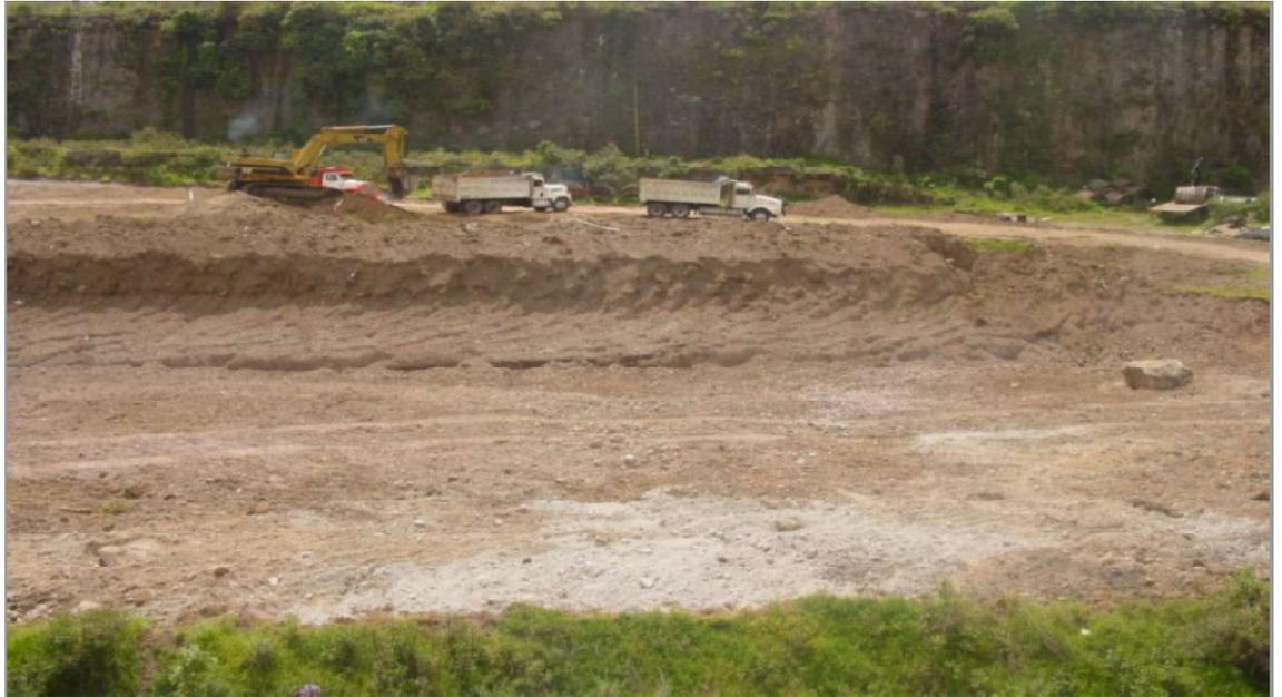
Se observa un terreno con alta resistencia debido a que este es tepetatoso. Excavación para el Conjunto Arcos Bosques, Torre 2, Santa Fe, Cuajimalpa, D .F.
