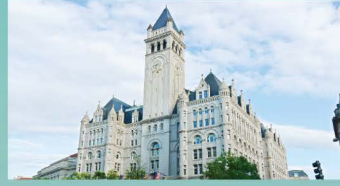
Eski Posta Ofisi (The Old Post Office)
