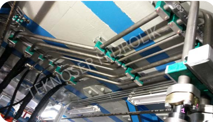
▼ Hidrolik borulama montajı
