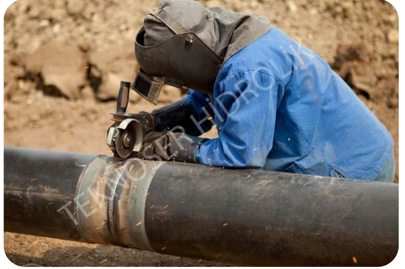
▼ Boru tadilat ve onarım işleri
