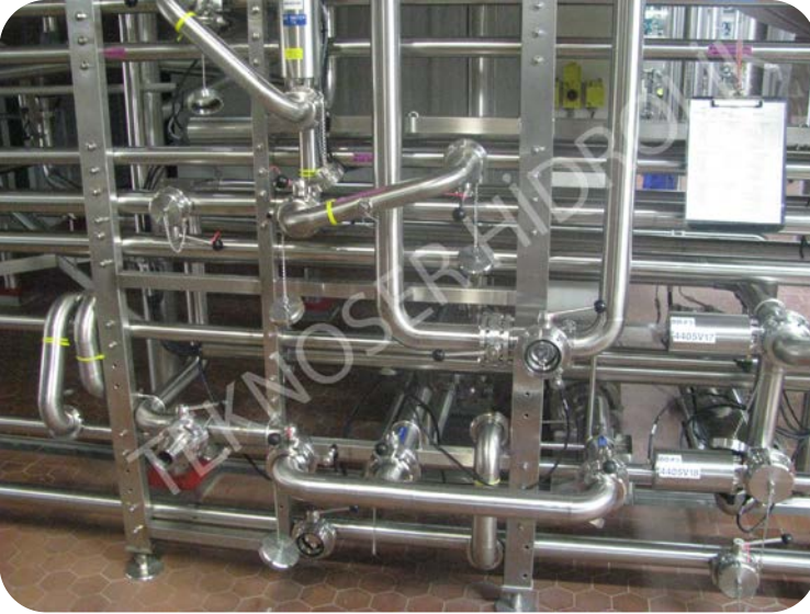
▼ Proses borulama montajı
