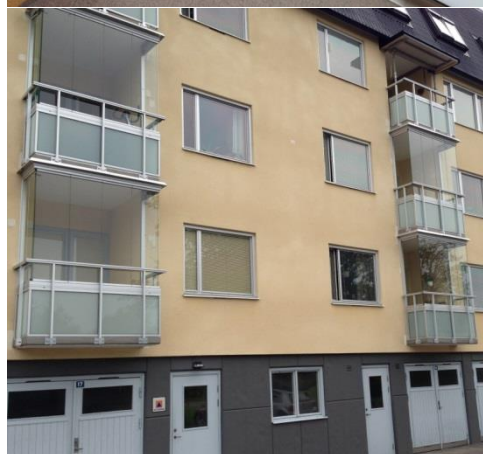
Bilderna visar andra installationer med samma profil som vi kommer ha men i övrigt annan utformning och färg.
