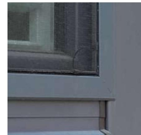
Bündig montierter Spannrahmen
