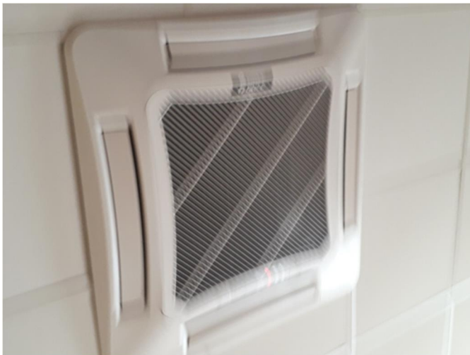
Ett av luft-luft värmeagregaten
