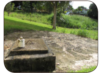
Mantenga sellados los pozos sépticos.
