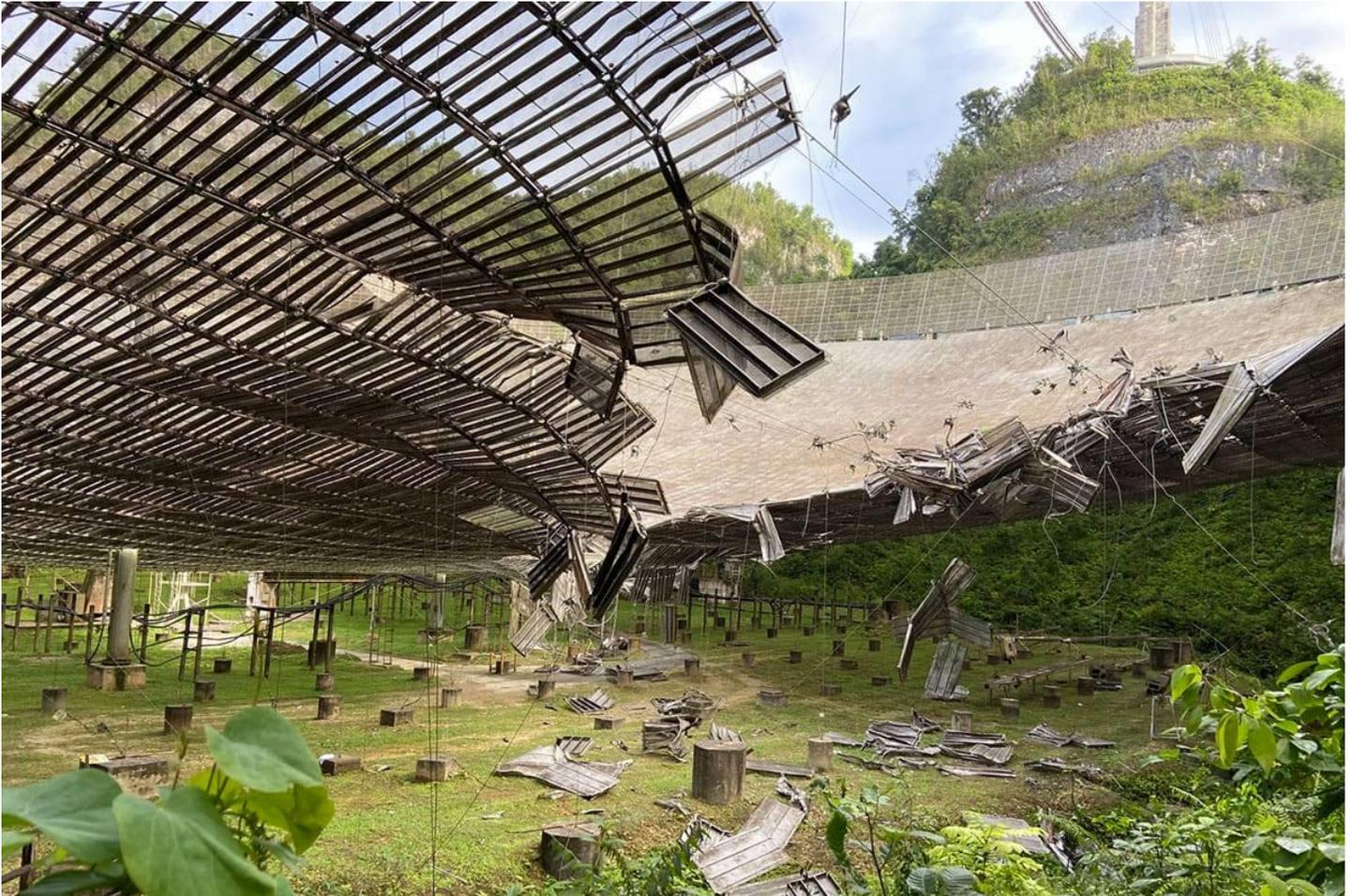
GRAVES DAÑOS EN EL OBSERVATORIO DE ARECIBO CUANDO UNO DE LOS CABLES AUXILIARES QUE AYUDA A SOSTENER UNA PLATAFORMA DE METAL EN SU LUGAR SOBRE EL OBSERVATORIO DE ARECIBO, PUERTO RICO, SE ROMPIÓ EL LUNES (10 DE AGOSTO) CAUSANDO UN CORTE DE 100 PIES DE LARGO EN EL PLATO REFLECTOR DEL TELESCOPIO
