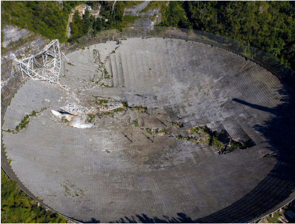
EL TELESCOPIO COLAPSÓ ANTES DE SU DEMOLICIÓN PROGRAMADA. (FOTO DE RICARDO ARDUENGO / AFP VÍA GETTY IMAGES)
