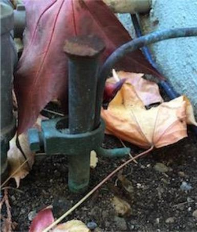
*UNA ESTACA DE METAL CLAVADA EN EL SUELO JUNTO A UNA CASA. EL CABLE SUJETADO A LA ESTACA SE CURVA HACIA LA DERECHA PARA PROPORCIONAR LA REFERENCIA DE SEGURIDAD DE TIERRA PARA EL SISTEMA ELÉCTRICO DE LA CASA.*
