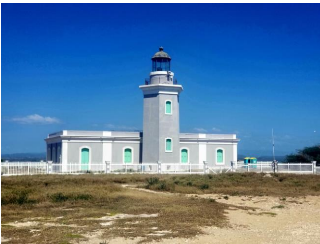
ACTIVACIÓN FARO LOS MORRILLOS PUR-002
