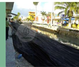
**Fabricados con láminas de polietileno / polipropileno de alta densidad formando estructuras tridimensionales semirrígidas de forma panel para confinar materiales de relleno granulares y suelos. Deben garantizar alta resistencia a la tensión, rigidez, contención y estabilidad tridimensional.**
