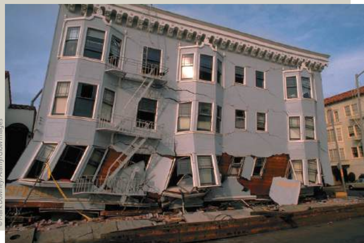
Edifício destruído por terremoto em São Francisco, Califórnia, EUA, 1989.
