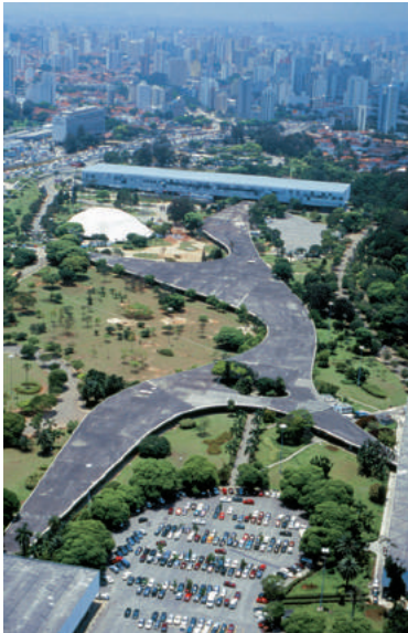
Vista aérea da Marquise do Parque do Ibirapuera, São Paulo (SP).
