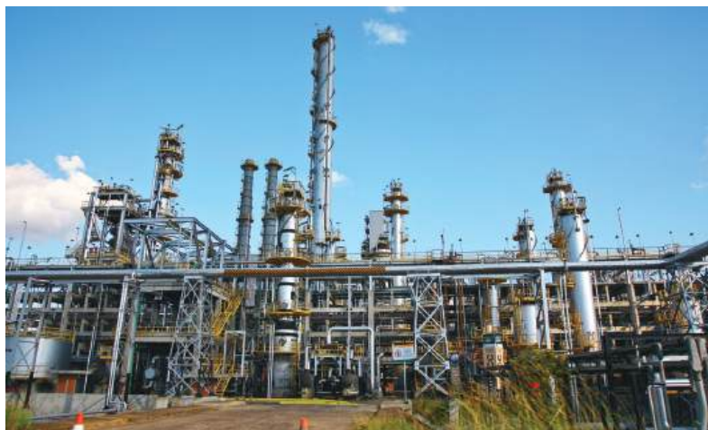
Torre de destilação de uma refinaria de petróleo.
